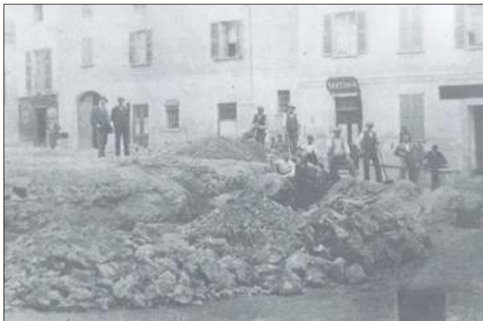
Demolizione della pretura
