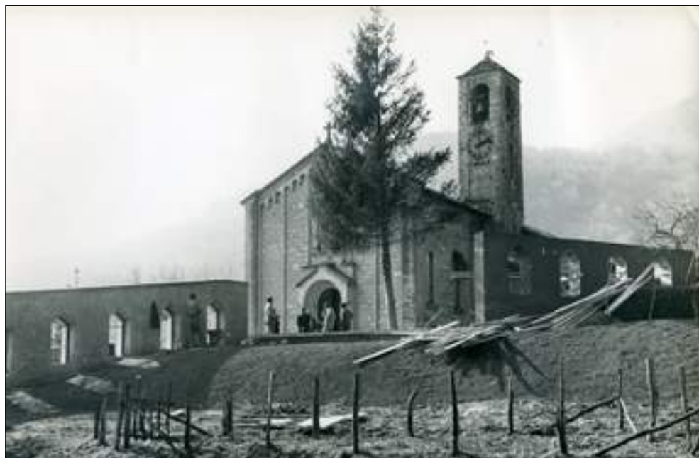
Arcumeggia, lavori per la realizzazione della Via Crucis, 1959
