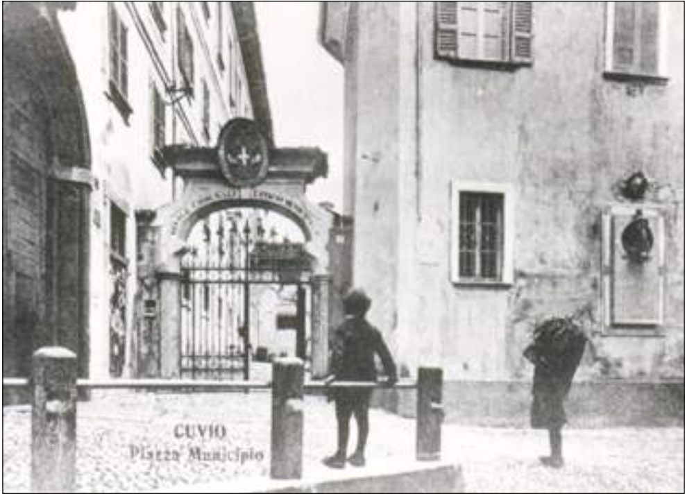
Edificio della pretura (a destra) prima della demolizione
