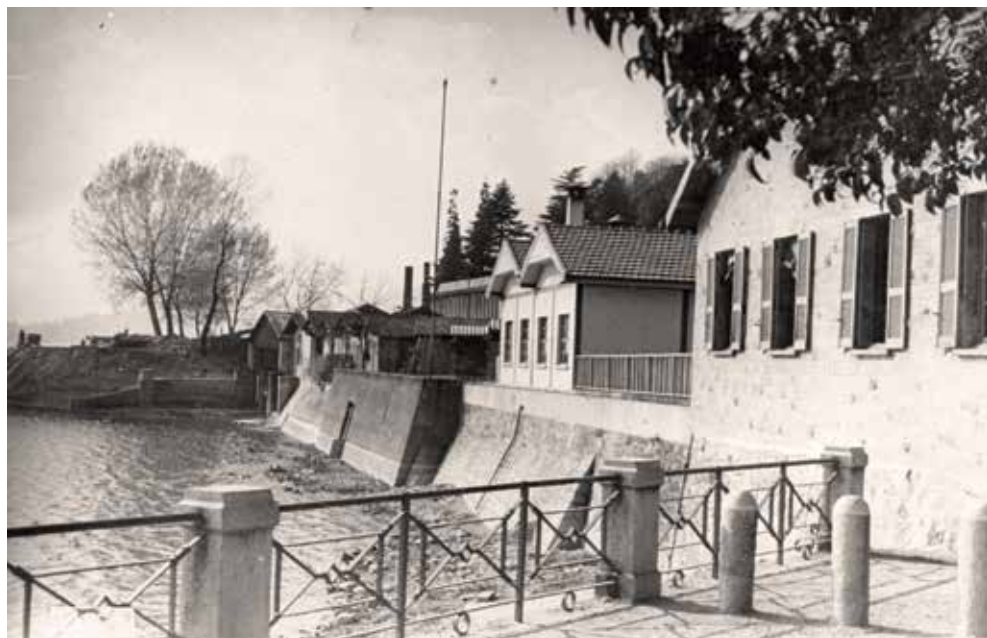
Stabilimento Lago (Archivio privato)
