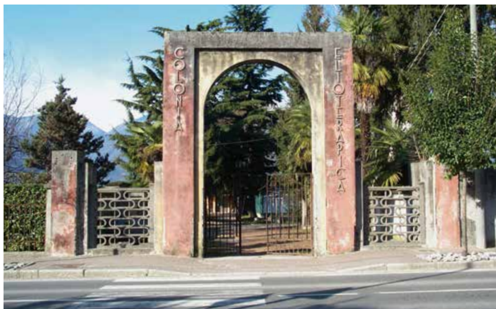
Il portale di ingresso alla Colonia elioterapica prima dei restauri del 2011
