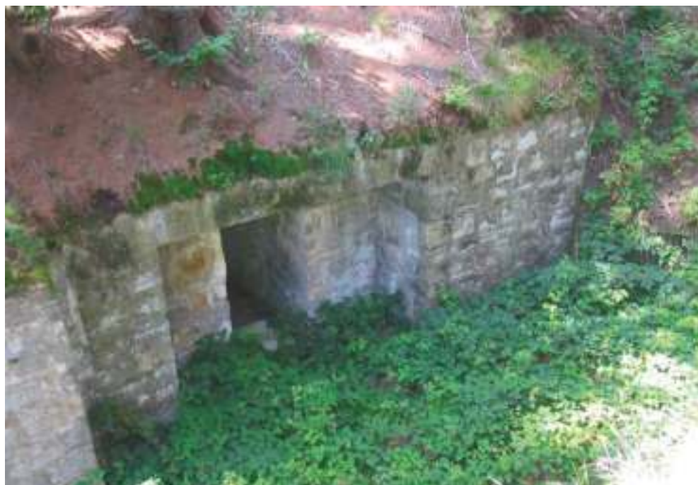
Montegrino Valtravaglia, batteria all'aperto
