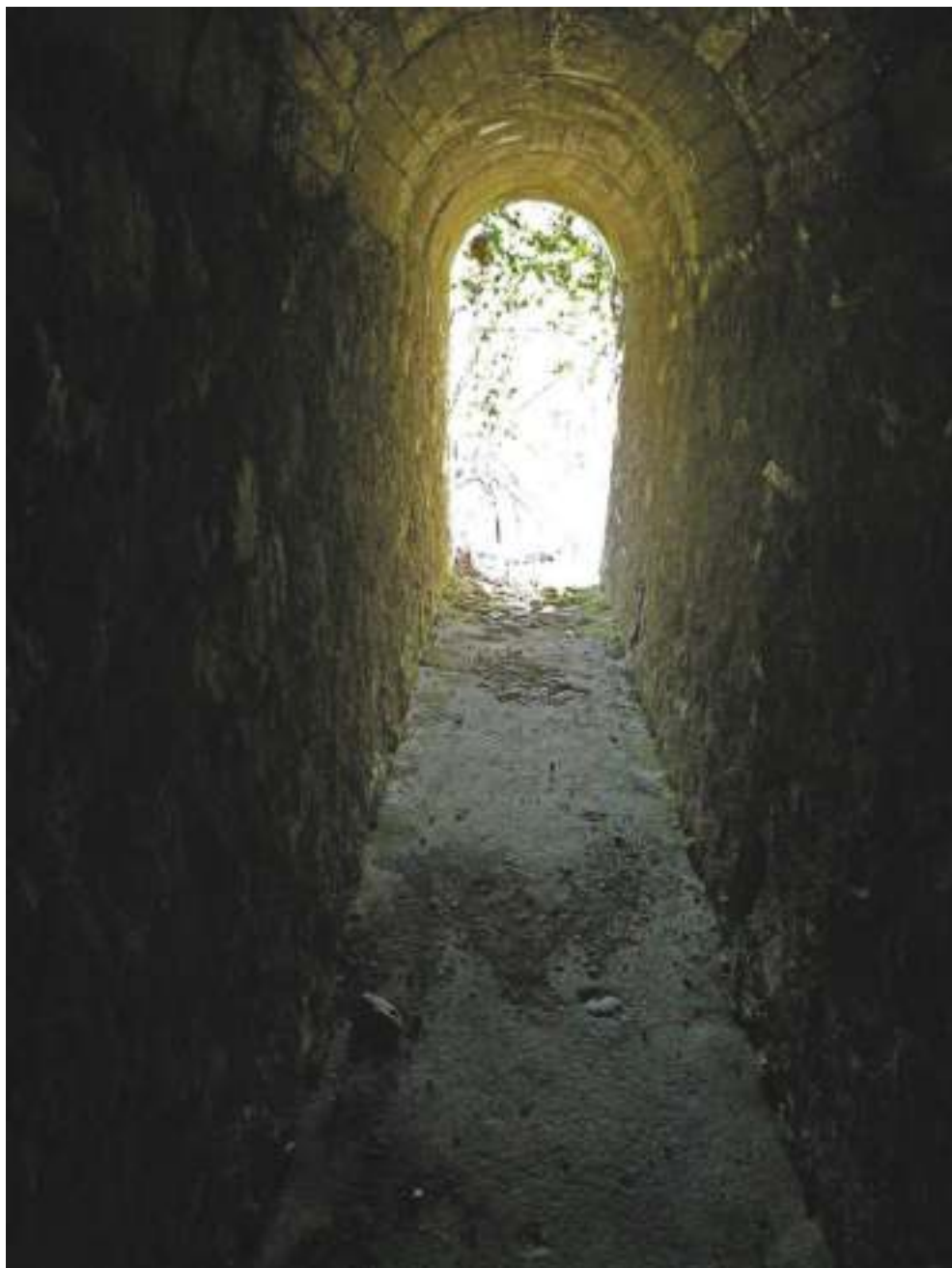
Germignaga, ingresso postazione sul torrente San Giovanni
