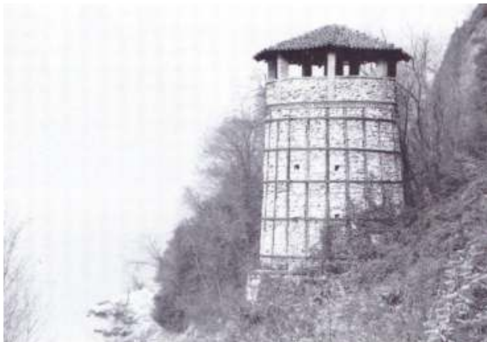
Ispira, fornace per la produzione della calce
