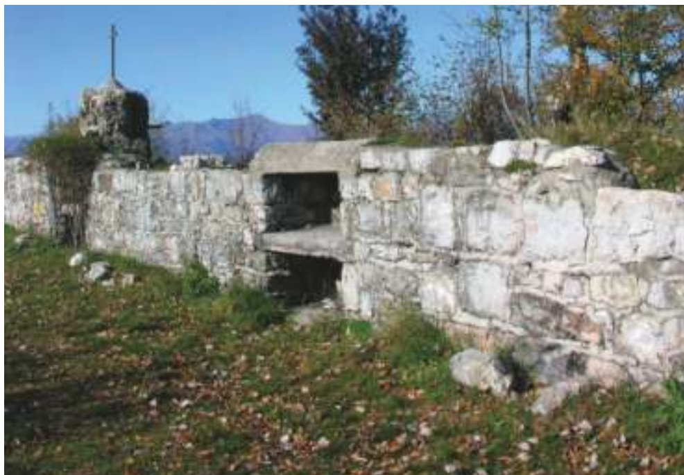
Orino, batteria all'aperto "Forte di Orino"
