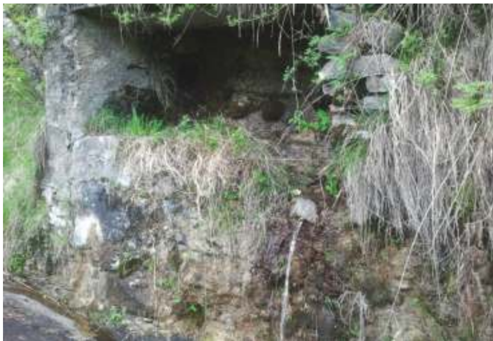
Strada ex militare Brissago-S.Michele, fontana scavata nella roccia
