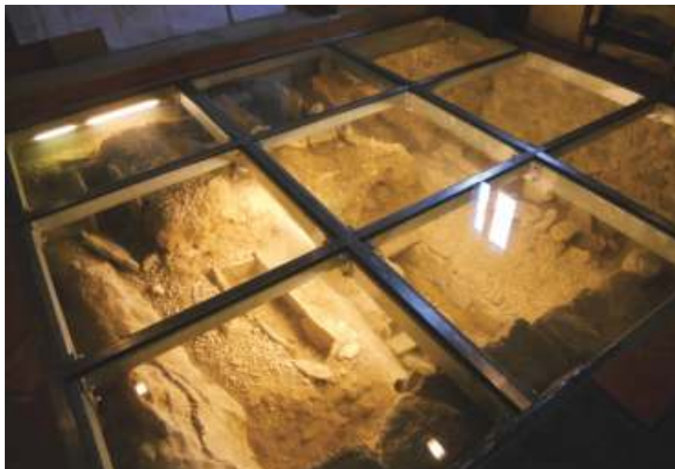
Il nuovo pavimento in vetro che valorizza le antiche strutture della chiesa medievale
